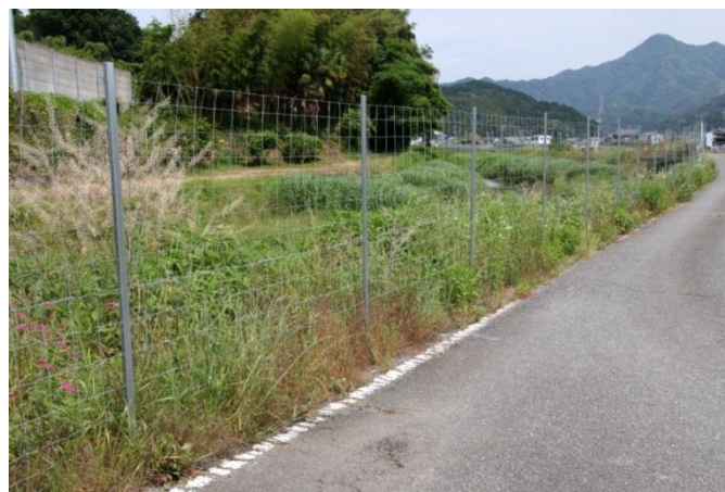
動物侵入防止柵の設置
