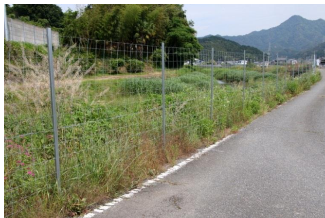
動物侵入防止柵の設置
